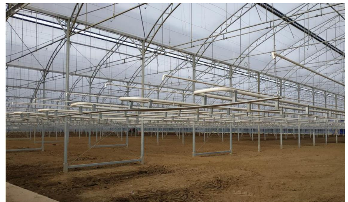
☞ Photographie 7 : Serres avant plantation en février 2020 Système de relevage des rails pour amendement du sol
