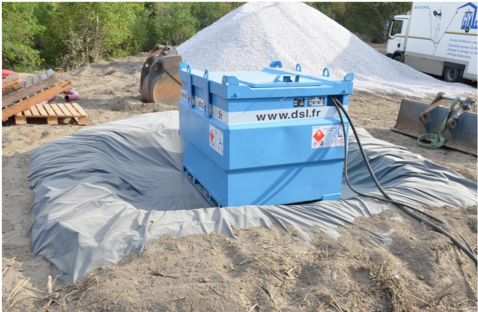
☞ Photographie 25 : Mise en place d'une aire étanche autour d'un groupe électrogène
