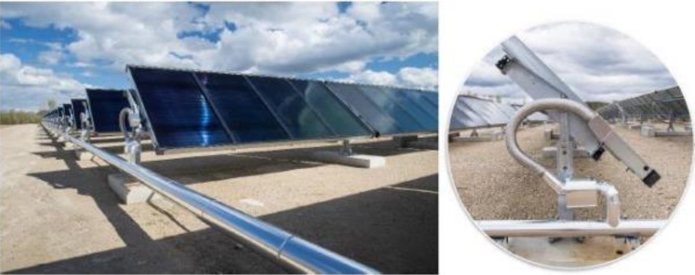
Figure 3 : A gauche vue des capteurs solaires avec tracking, à droite vue de profil du système de tracking (source : société newHeat pour le projet Condatsol)
