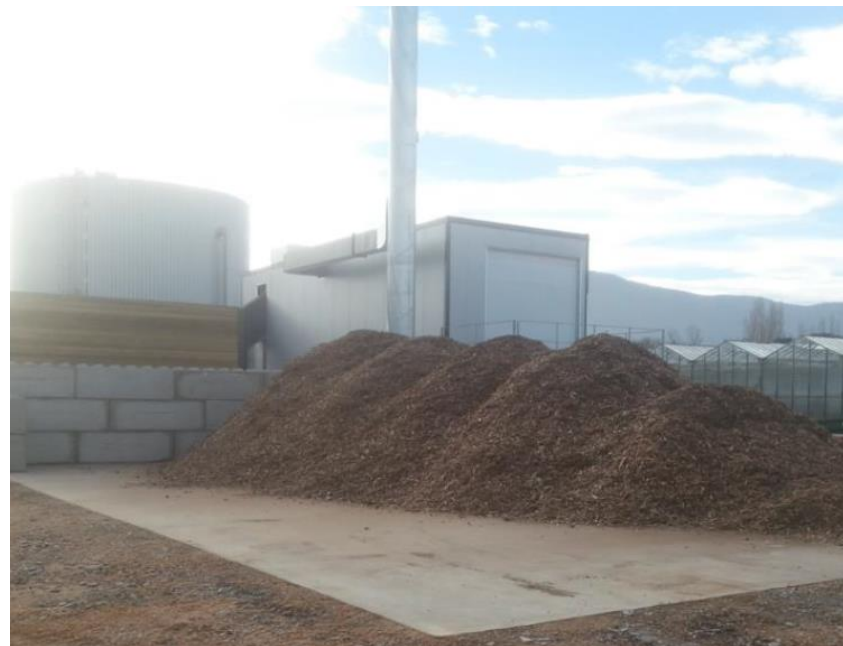
☞ Photographie 8 : Chaudière biomasse et stock de plaquettes forestières
