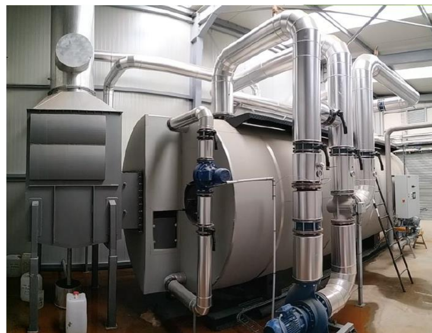
☞ Photographie 8 : Chaudière biomasse et stock de plaquettes forestières
