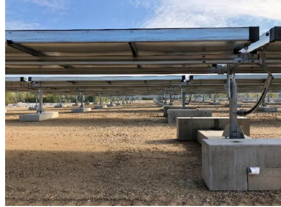
Ancrage par plots béton
