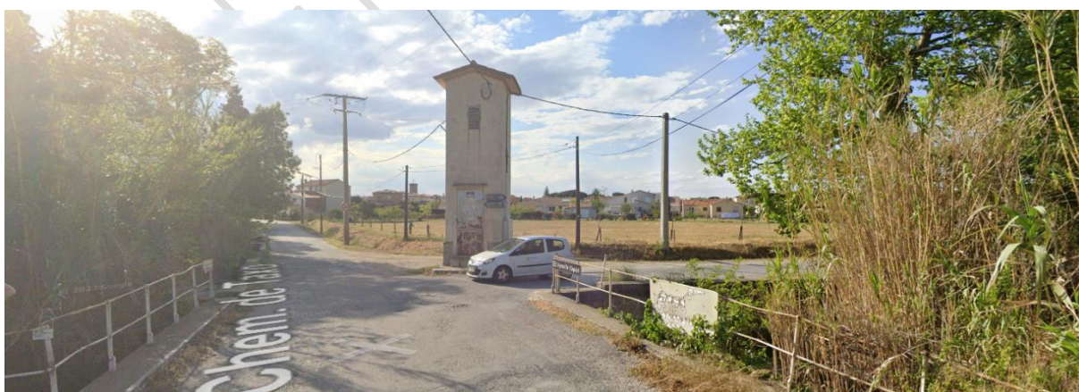
Figure 20 : Photographie d'entrée de ville. Source : google street view, avril 2023
