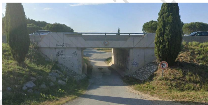
Ouvrage de franchissement de la RD618 modérément favorable au passage de la faune
