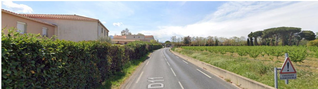
Figure 21 : Photographie d'entrée de ville. Source : google street view, avril 2023
