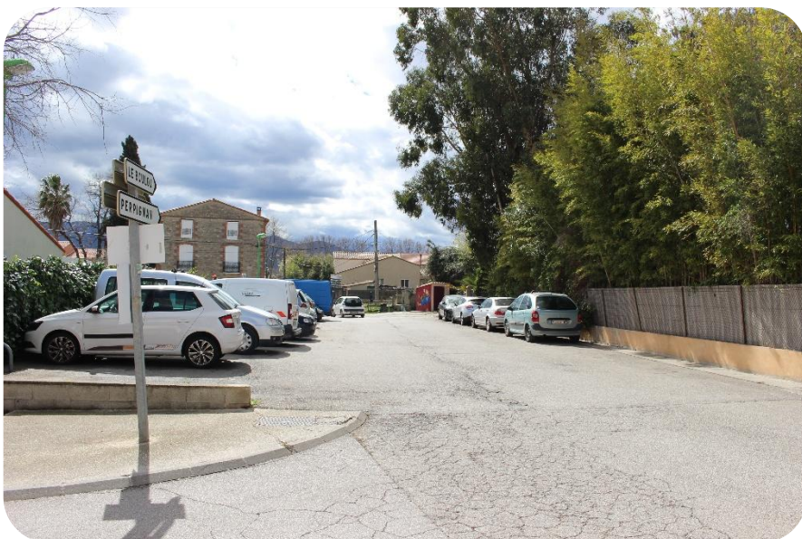
Aire de stationnement existante
