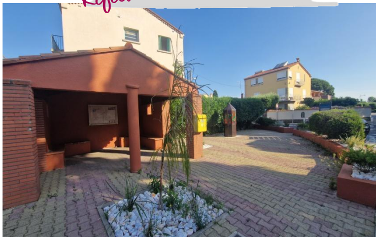
Réfection de l'arrêt de bus
