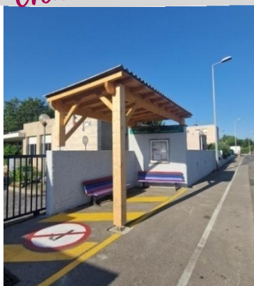
Création d'un préau
